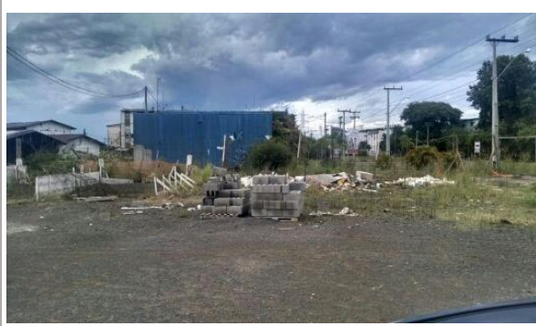
Fotografia 1 Vista do acesso ao lote e canteiro de obras
