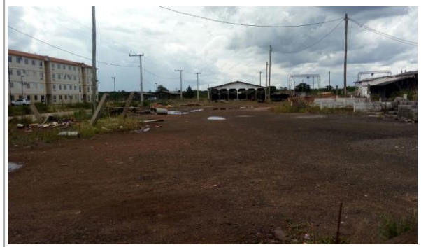
Fotografia 4 Vista da estrutura inicial do canteiro de obras
